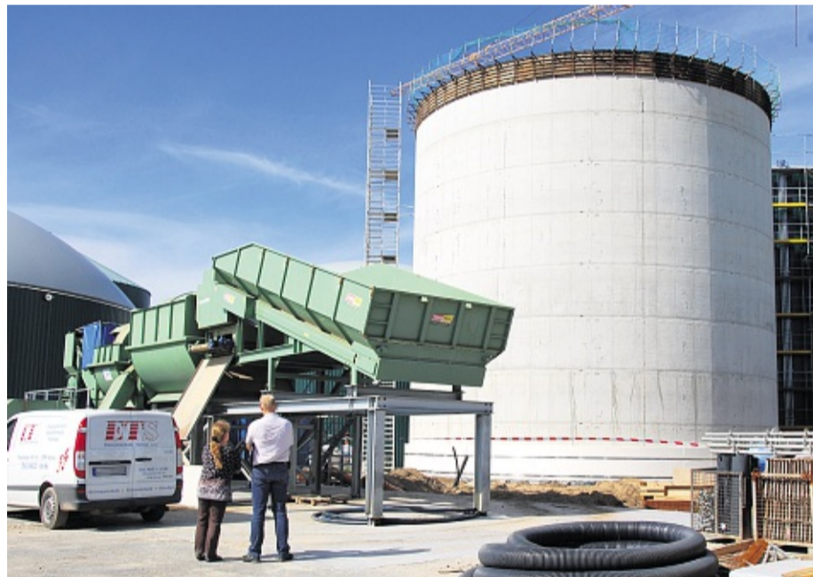
Neue Rübenaufbereitung (vorn) und die beiden neuen Fermenter – die Biogasanlage in Schuby wächst. HARDING (2)
