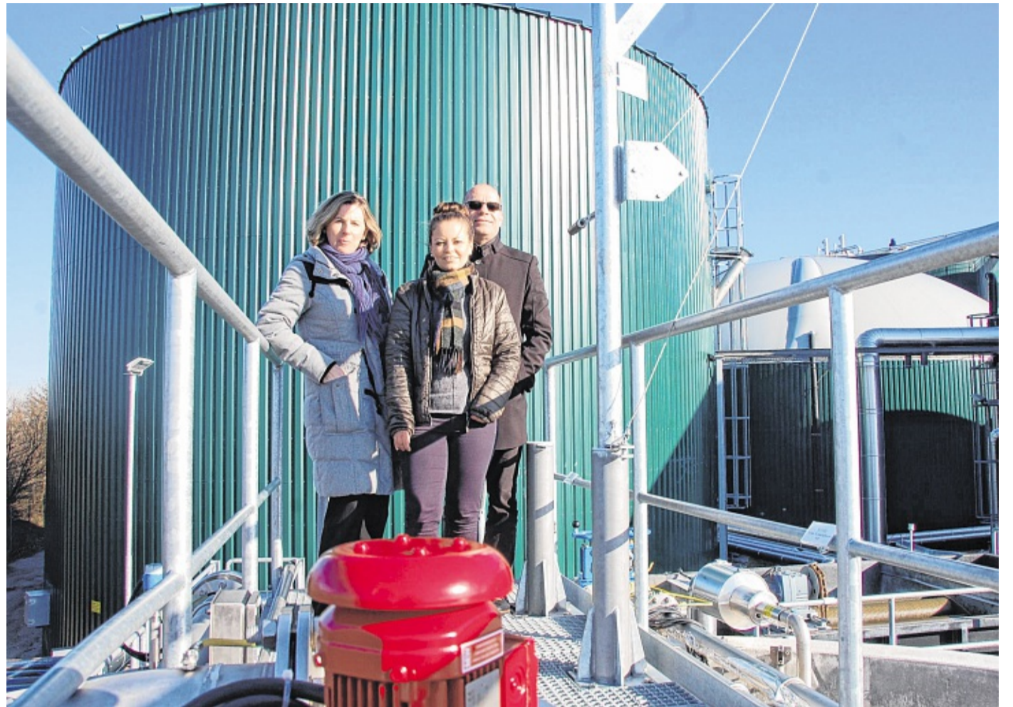
Wiktorja Vith (v.l.), Maja Bugdoll und Ulf Eckstein freuen sich über den reibungslosen Betrieb der Wasseraufbereitung.
