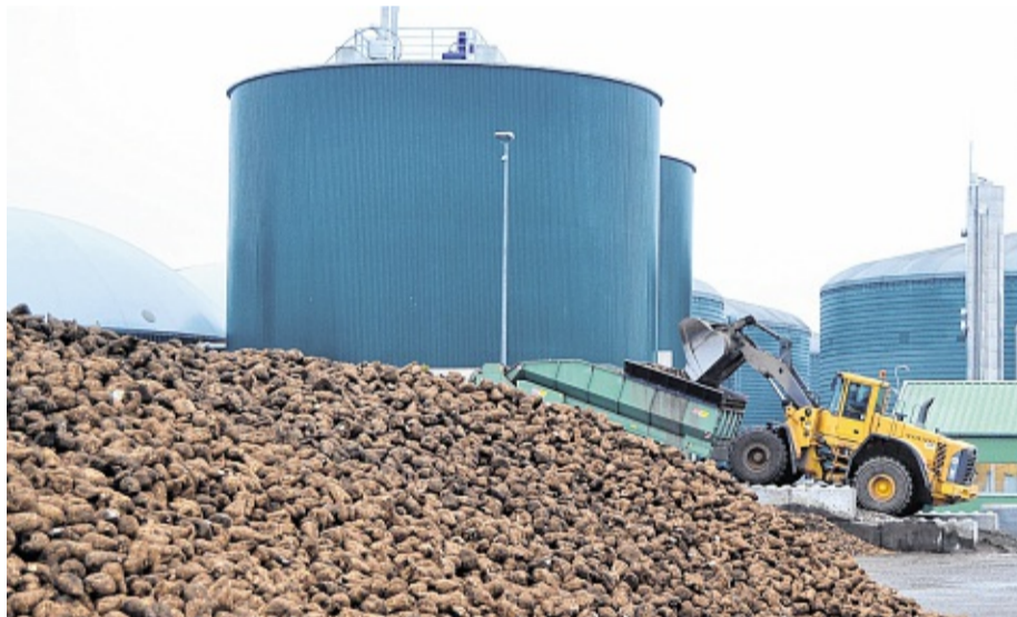
Die große Biogasanlage in Schuby ist die einzige im Land, die vollständig auf Rüben als Substrat setzt.
